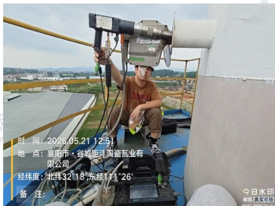
附图 2 现场检测照片
